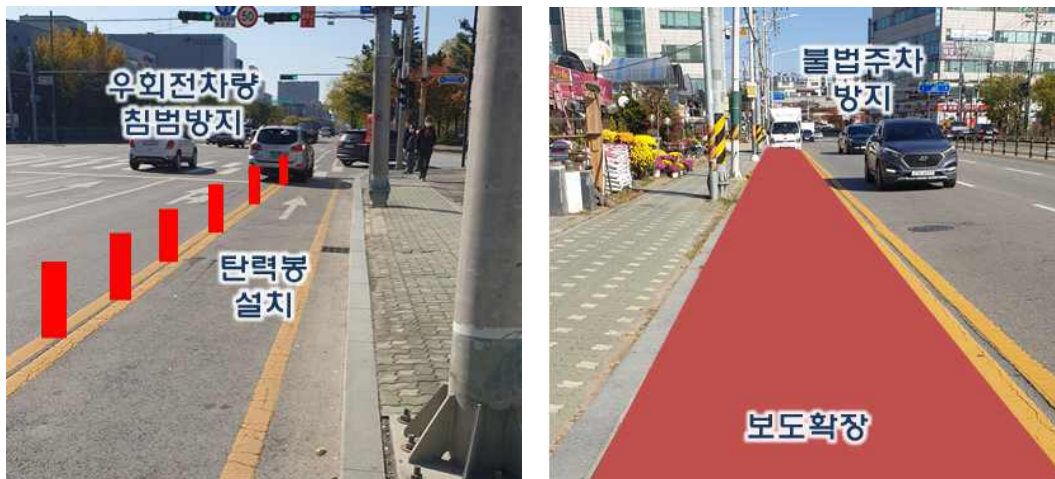
[그림 5-2] 도로다이어트에 따른 자전거 전용차로 개선방안
