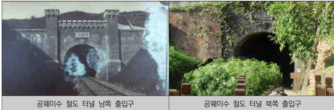
그림 3-11 | 대만 마오리 공웨이수 철도 터널 과거 시기 모습
